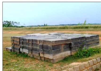
Sur le canal, 196 plaques en béton armé seront posées lorsque HSA sera en fonction. Il en est fabriqué une tous les deux jours.
