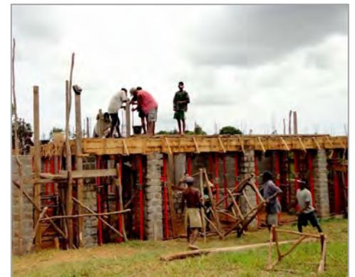
**A** lors que la base des constructions ainsi que les piliers des varangues sont en moellons de granit, les murs devaient être en briques crues pressées avec un
