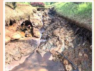
Et voilà la prise d'eau avec sa crépine. Les pierres seront remplacées par un petit ouvrage maçonné pour maintenir l'ensemble en position
