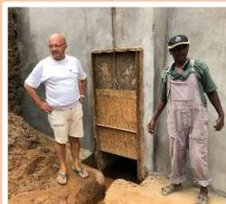
On essaie de passer par la galerie de vidange, mais la trappe est grippée... On va donc vider le bassin : pas d'autre solution que le siphonage. Et on creusera la galerie en sous-œuvre, sous la trappe, pour passer le tuyau.
