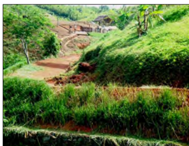
Rien n'a bougé, là où les travaux étaient terminés
