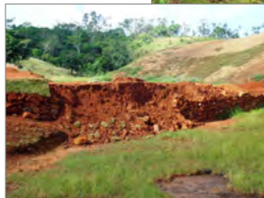
Glissements de terrain et éboulements
